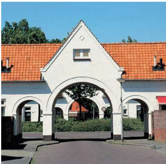
Fig.3, toegang tot de arbeiderswijk Pathmos (1814-1828).
